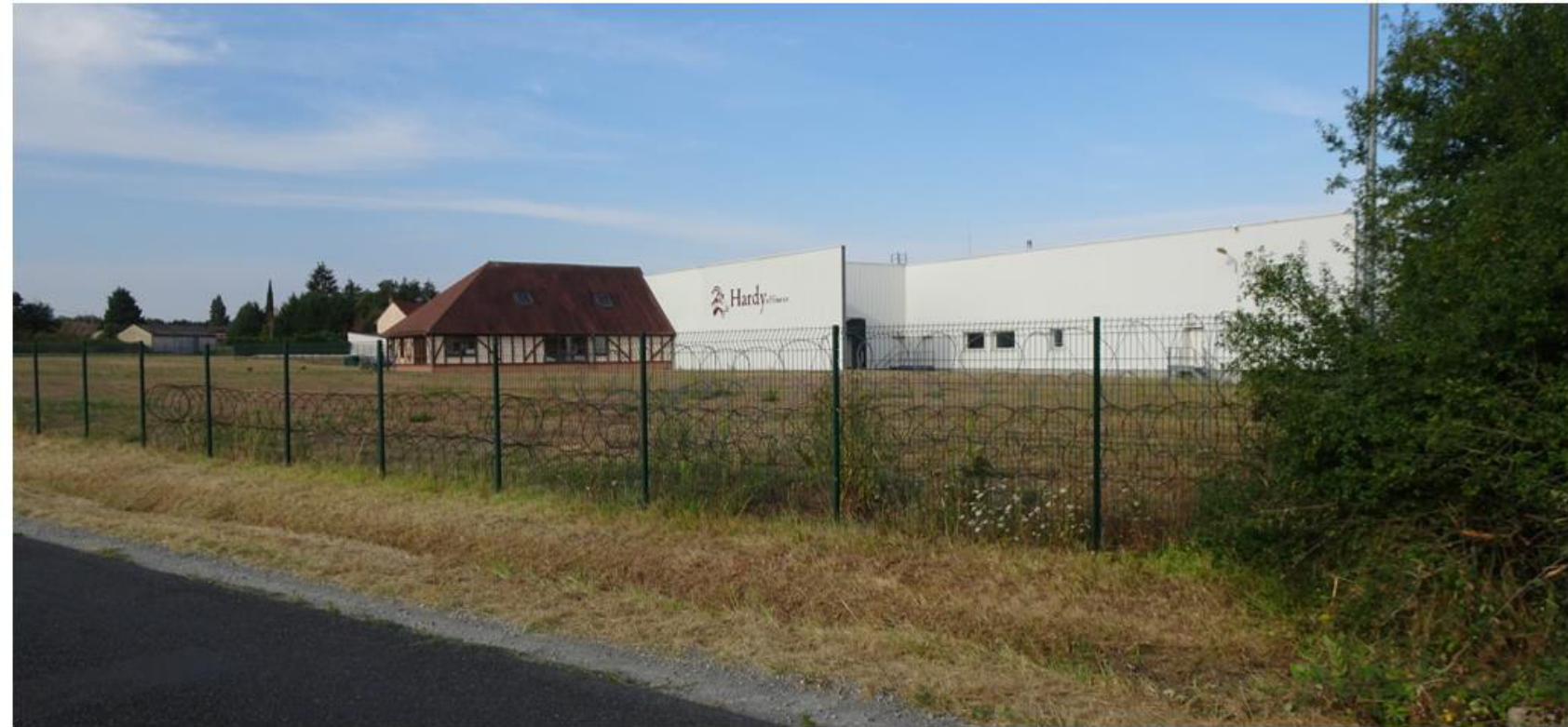
Figure 165 : Photographie d'une usine de production de fromage (Crédit photo : NCA Environnement)
