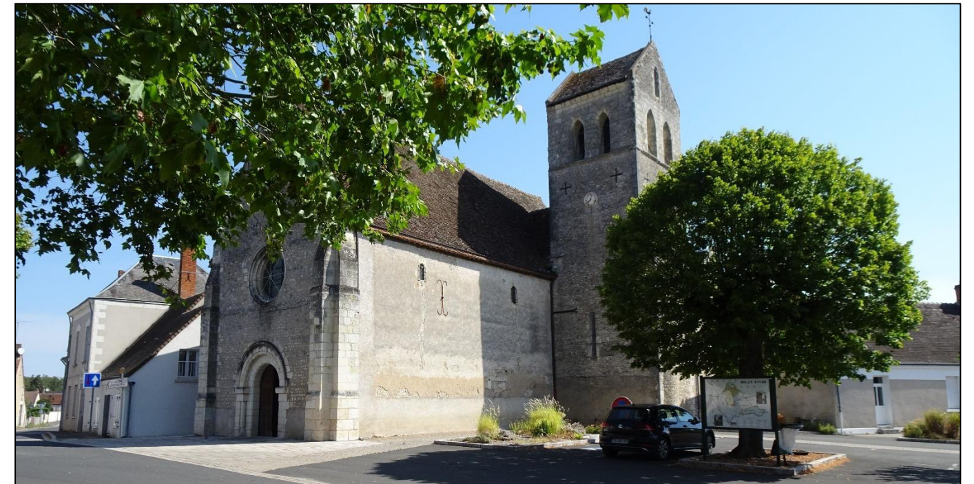
Figure 144 : Prise de vue 1 - photographie de l'Eglise Saint-Aignan (Crédit photo : NCA Environnement)
