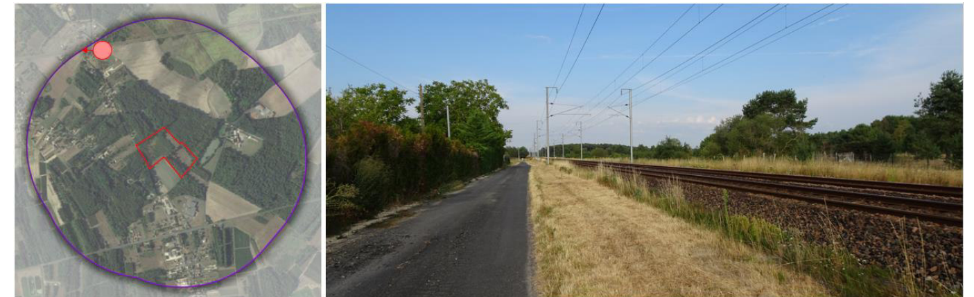
Figure 179 : Photographie de la voie ferrée traversant l'AEI (Crédit photo : NCA Environnement)
