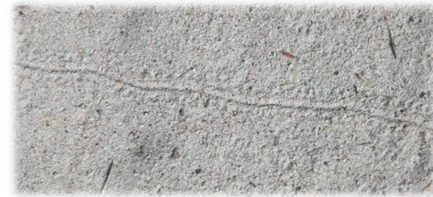
Figure 97 : Traces de Lézard des murailles, photo prise sur site, ©NCA Environnement 2020
