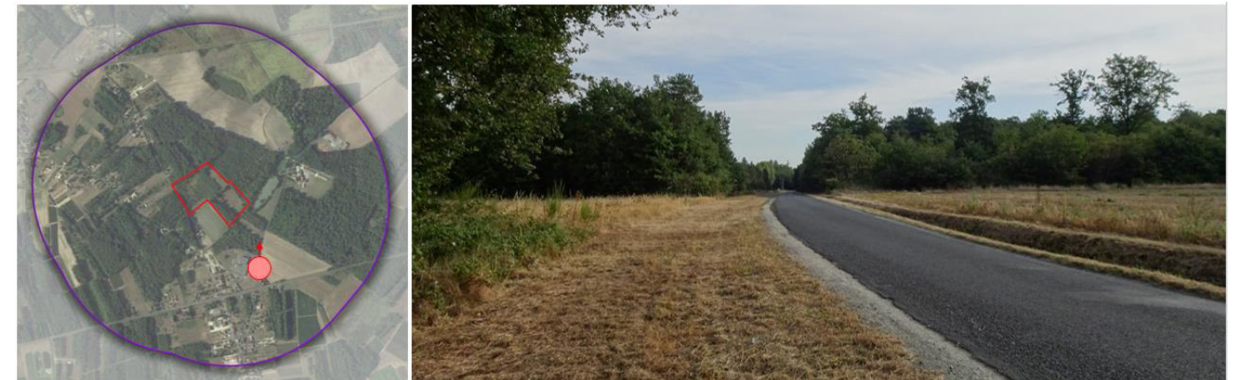
Figure 173 : Photographie d'une route et de zones boisées qui délimitent les surfaces cultivées (Crédit photo : NCA Environnement)
